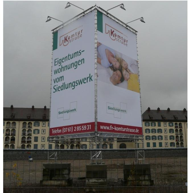
viereitiger, 10 m hoher Werbeturm mit jeweils 4 x 7 m großen Blockout-Planen sowie Beleuchtungsanlage mit je zwei HQL-Strahlern pro Seite
