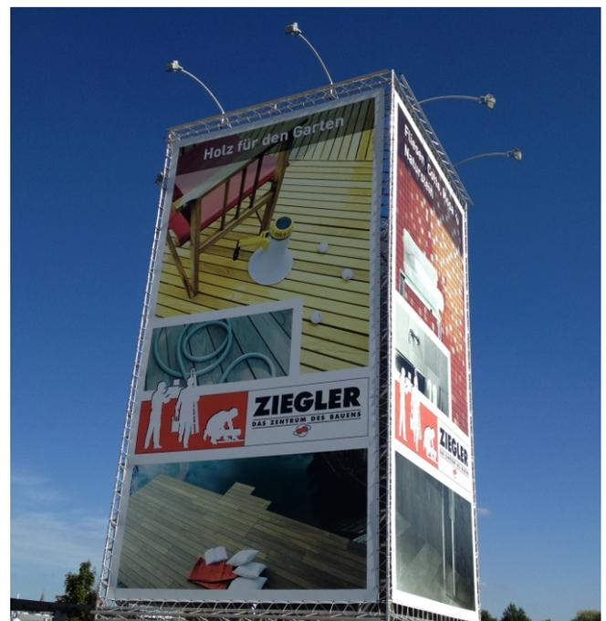
viereitiger, 12 m hoher Werbeturm mit jeweils 5 x 9,5 m großen Blockout-Planen sowie Beleuchtungsanlage mit je zwei HQL-Strahlern pro Seite
